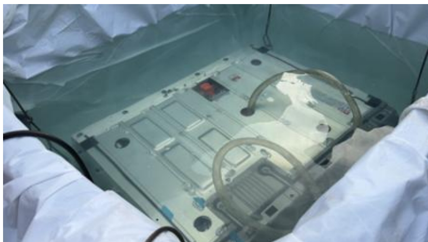
図 2-29.LiB へのポンプの設置方法（西日本オートリサイクル試験）
