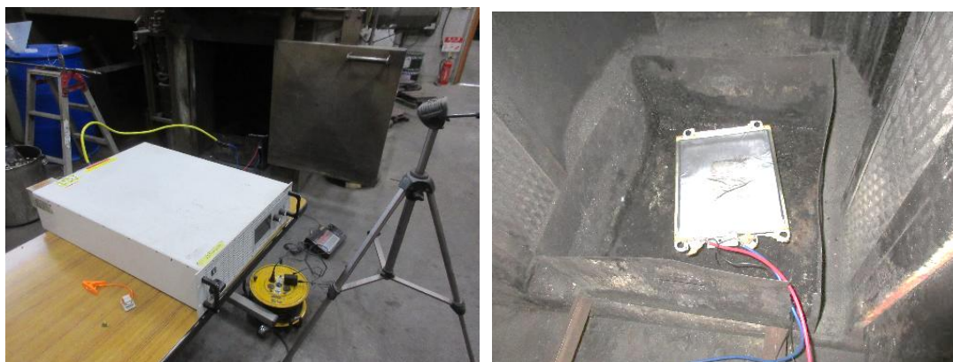
図 2-46. 電力回生式電子負荷装置（Elektro-Automatik 社製 EA-ELR91000-30） 30A と LiB
