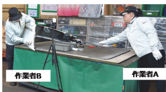
図 2-12.実際の2次解体現場
